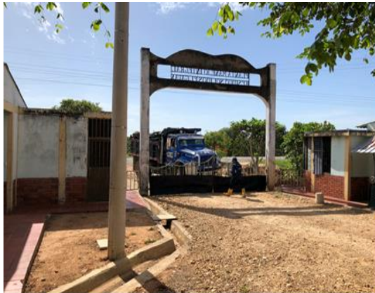
Figura 25. Planta de tratamiento de residuos sólidos EL GAVAN.
