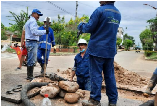
Fotografías: intervención de pavimento para reparación de manguera domiciliaria.
