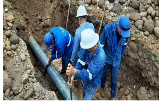
Fotografía: Mantenimiento por ruptura de tubería de 12" en la red de acueducto.
