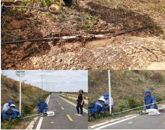
Fotografías: Reparación de la red de distribución de acueducto en el parque lineal.
