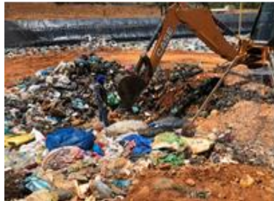
Figura 26. Trinchera de residuos sólidos en la planta de tratamiento del Gavan
