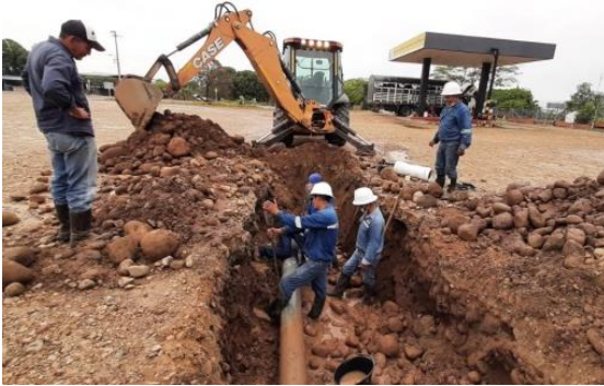
Fotografía: Mantenimiento por ruptura de tubería de 12" en la red de acueducto.
