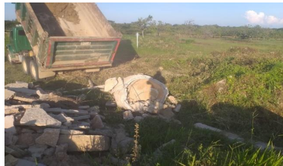
Figura 28. Disposición de residuos de construcción y demolición.
