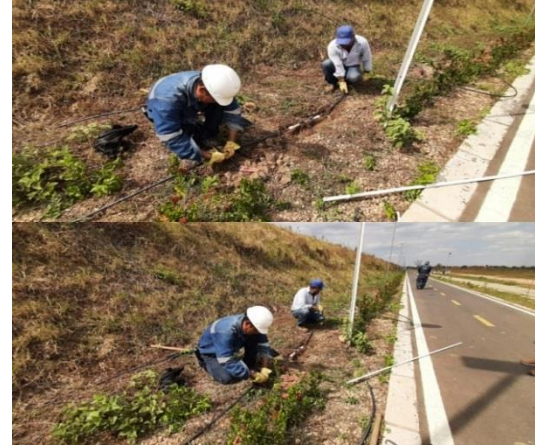
Fotografías: Reparación de la red de distribución de acueducto en el parque lineal.
